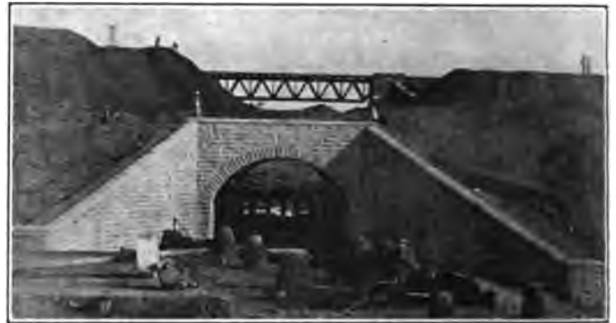
Typical Culvert, E. I. R.
